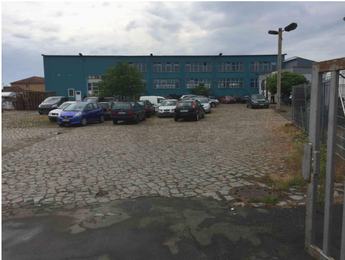
Abbildung 1: vorhandene große Halle mit befestigten Flächen
