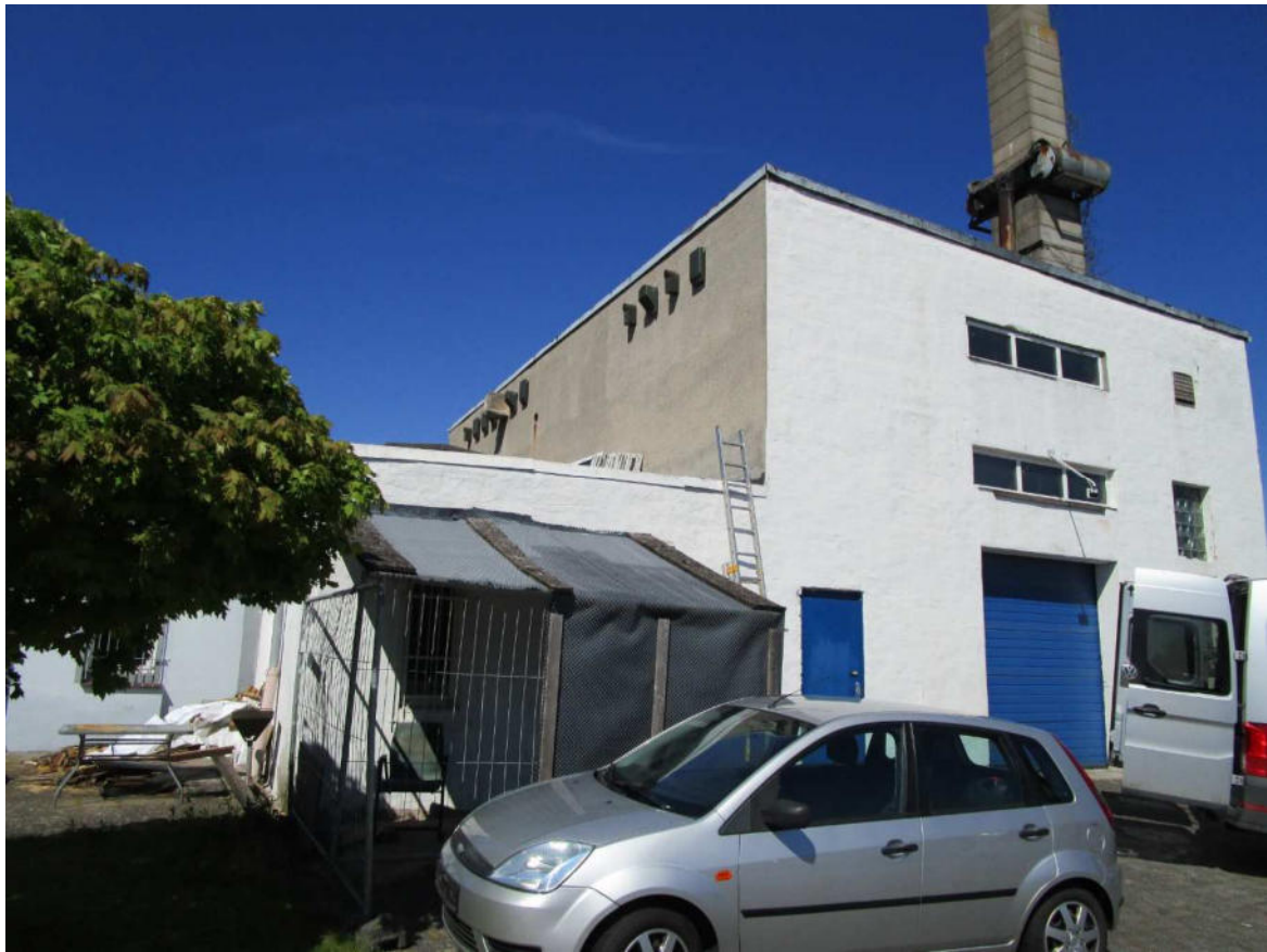
Abbildung 5: CEF-Maßnahme an Nachbargebäude Anfang Mai 2023 (Foto CKS)
