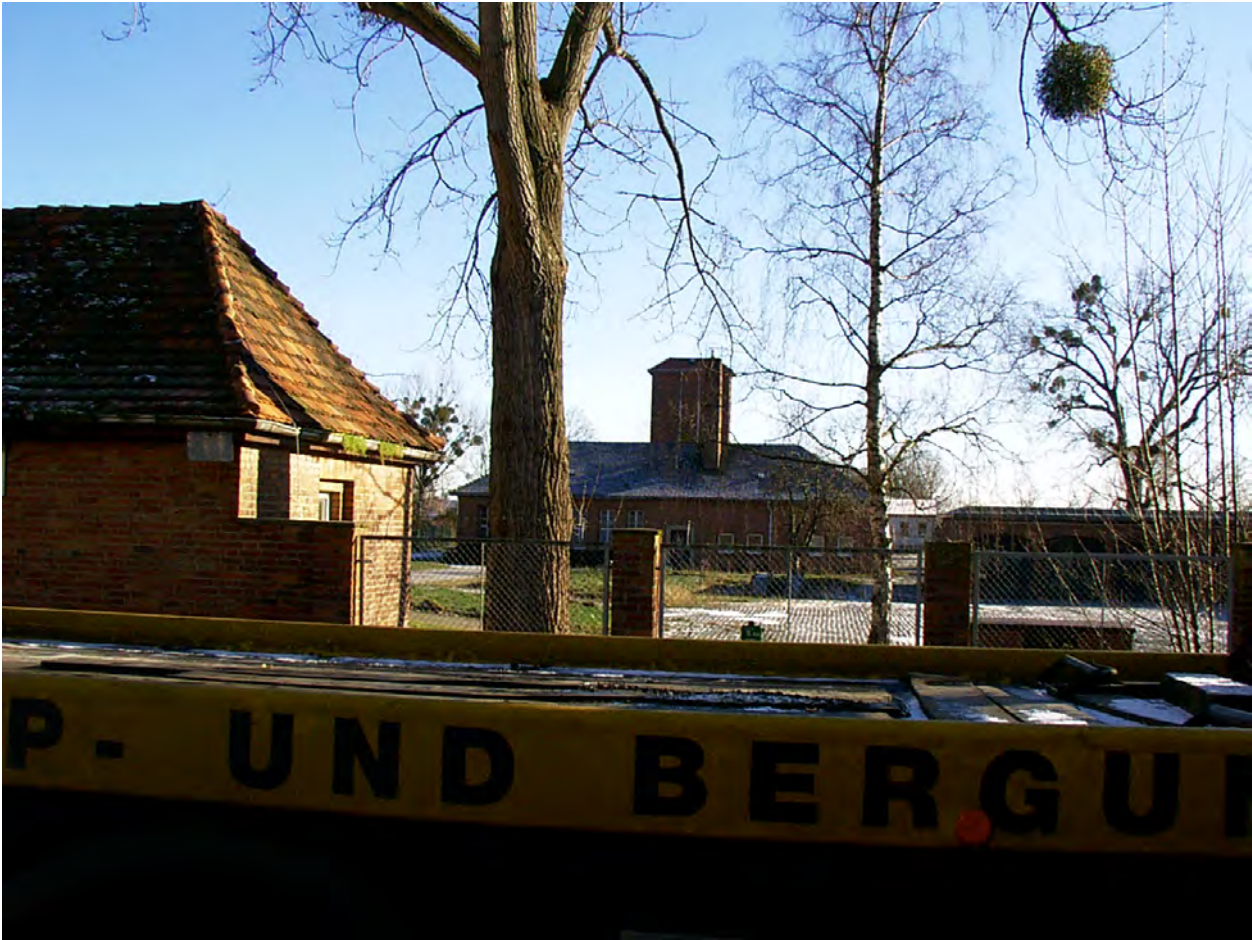
Das ehemalige Maschinenhaus mit Turm und Brachflächen auf dem Alten Klärwerk
