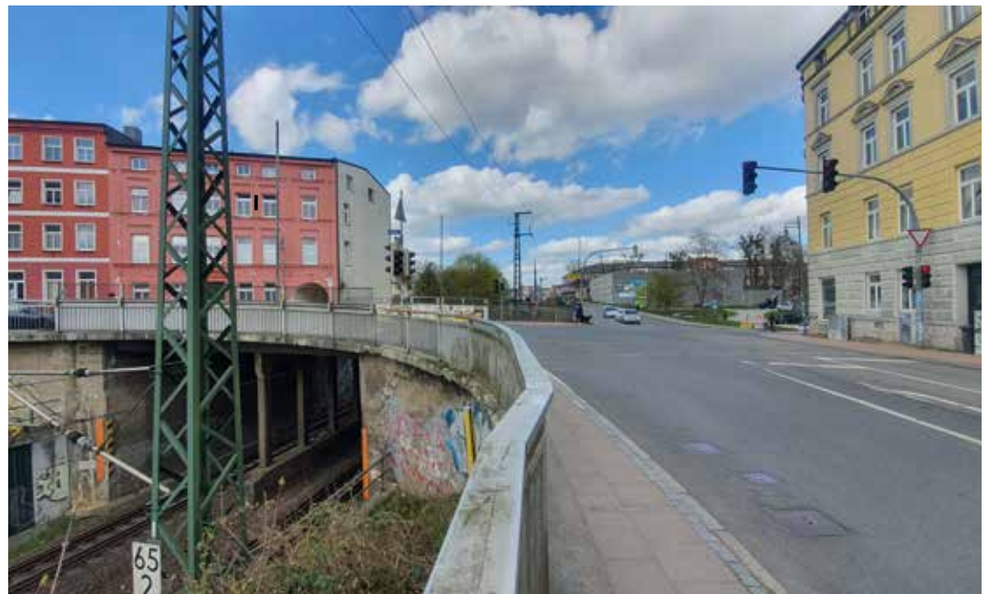
Der Ersatzneubau der Brücke kostet 16 Millionen Euro.
